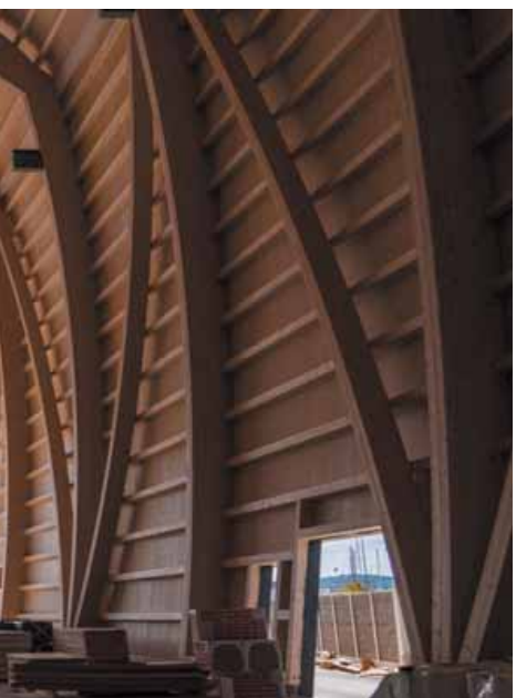
etato, visto dall'esterno (sopra) e dall'interno
